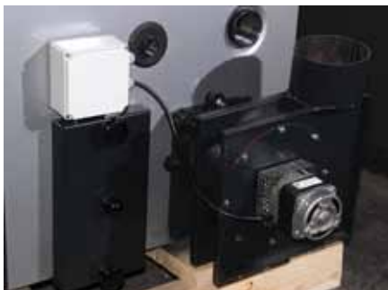
Savukaasupuhallin soviteosaan asennettuna.
