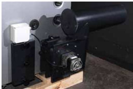
Jatkosola puhaltimeen asennettuna. Jatkosolan tuotennumero 5012981.
