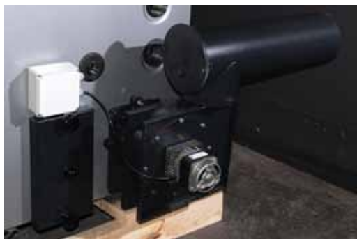
Förlängningskanal monterad på fläkten. Förlängningskanalens artikelnummer är 5012981.
