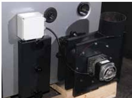
Rökgasfläkten monterad i adaptern.
