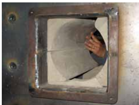
6. Övre delen av främre teglet. De övre delarna stöds mot varandra från mitten med till exempel en lämpligt stor träbit.
