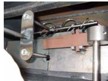
9. Asenna konvektiokanavan kannet ja keinuvipu paikoilleen.
