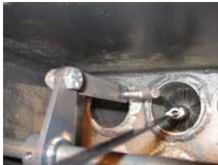
5. Nuohoa konvektiotuubien pinnat pyöreällä harjalla ja poista lentotuhka. Työnnä harja alas asti ja nosta takaisin ylös.
