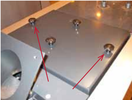
1. Öppna de yttre stjärnvreden och lyft av sotluckan.
