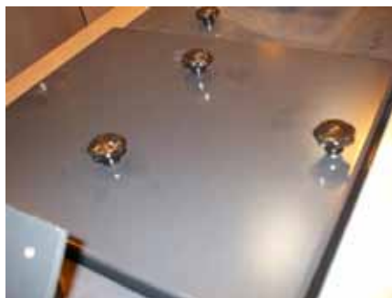
8. Sätt tillbaka sotluckan och skruva in stjärnvreden.
