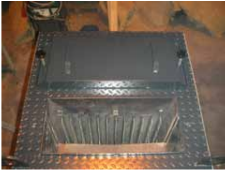
1. Avaa kattilan päällä olevat nuohousluukut.
