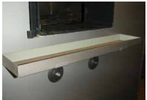
6. Tulipesä ei normaalisti vaadi erillistä puhdistamista. Oikein säädetty poltto pitää tulipesän puhtaana. Tuhkahylly asennettuna tulipesän luukun alle.
