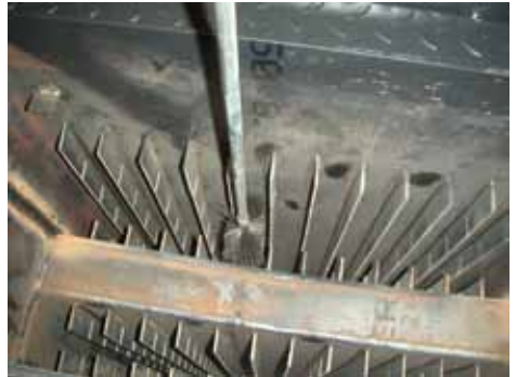
2. Kiinnitä harjaosa varteen ja harjaa sola kerrallaan.
