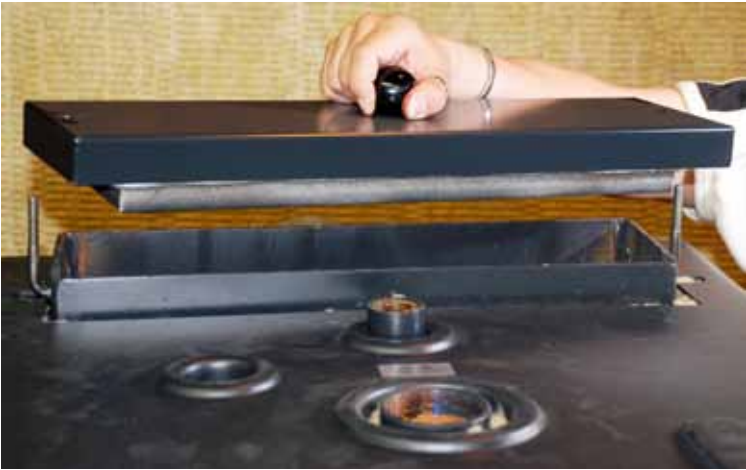
Irroita konvektorin luukku.
